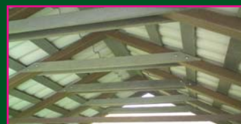
koňštrukcia plechovej strechy
