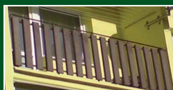
na žel. koňštrukciu
