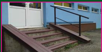
rekonš. betónového schodišťa
